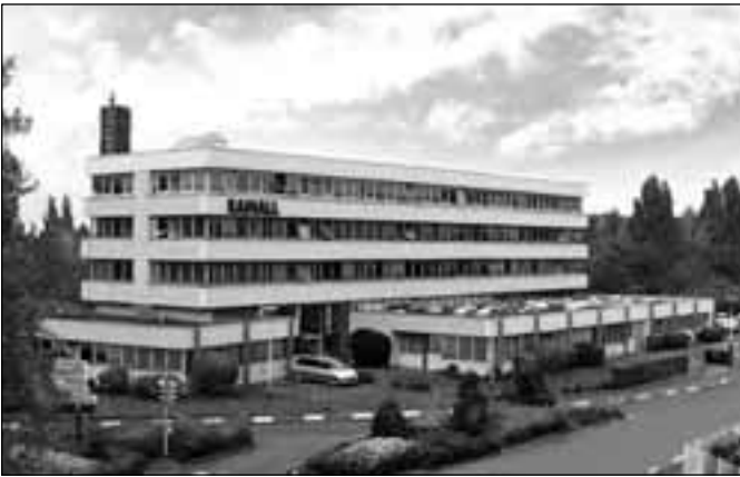
Head Office - Rosny sous Bois
